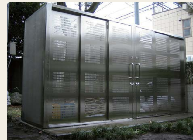
コンクリートの基礎の上に扉や側面・背面を取り付けて製作した集積場です。底板は基礎をそのまま使用しています。
