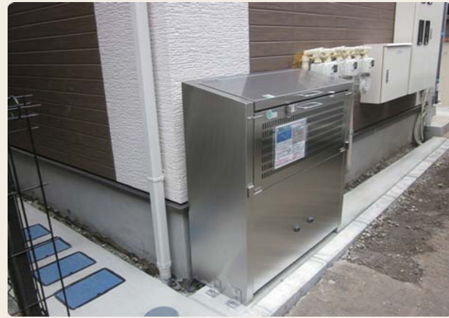
境界線よりはみ出さないように、奥行400mmで製作した、EMDSスリムのオーダーです。
