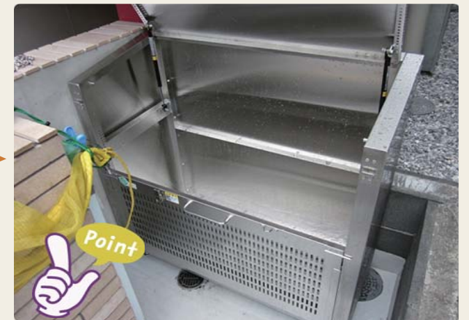
正面上の扉を手前に倒せない狭さなので、扉を上下にスライドする仕様になりました。これで回収業者の方も楽に回収出来ます。
