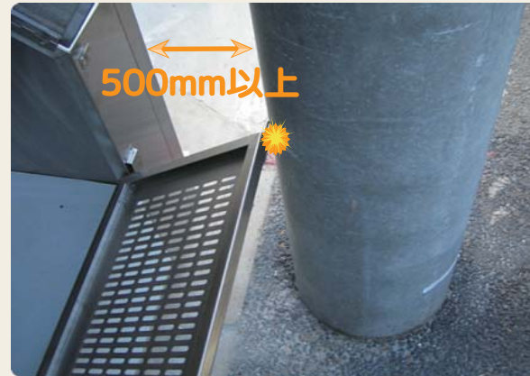
正面上の扉が手前に倒れなくなりますので、 正面より500mm以上あけて設置します。
